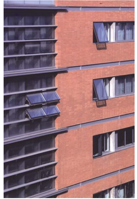
Façades avec bandes filantes horizontales et ouvrants cachés
