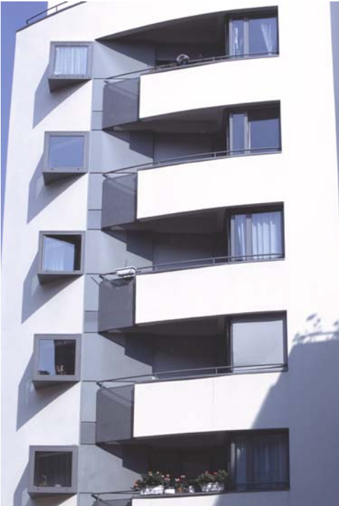
Fenêtres à ouvrants cachés intégrées dans les bow-windows
