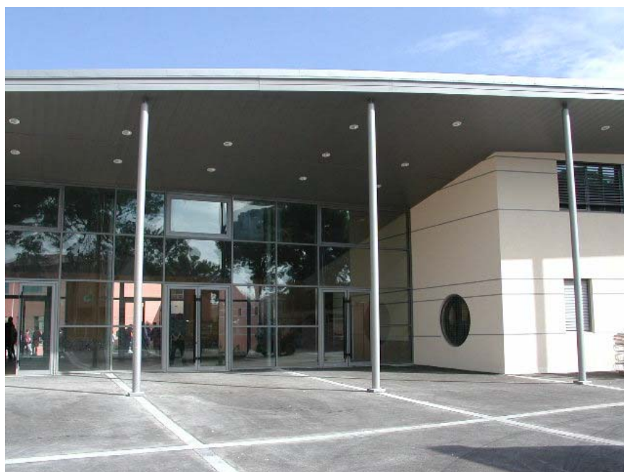
Entrée principale : la façade mur rideau traditionnelle est protégée par une vaste avancée de toit qui fait de l'ombre en été
