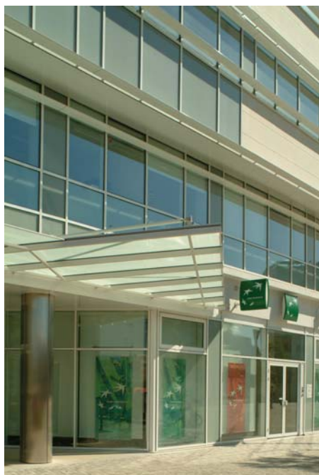
Auvent suspendu (haubanage par tirants fixés à la façade) réalisé en ossature alu et verre sablé avec chéneau encastré et descentes d'eaux pluviales cachées.
